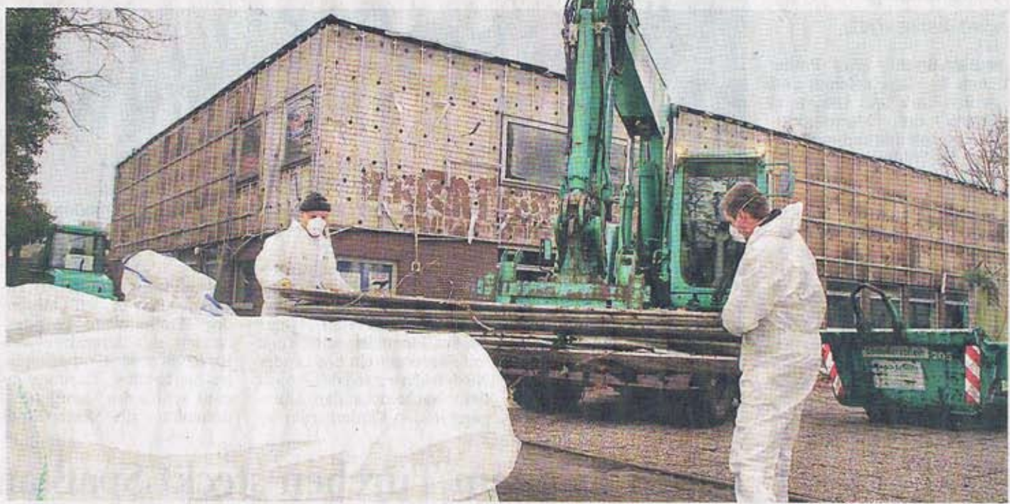
Vorsichtig tragen die Mitarbeiter die asbesthaltigen Wandplatten in ein Folienpaket.
