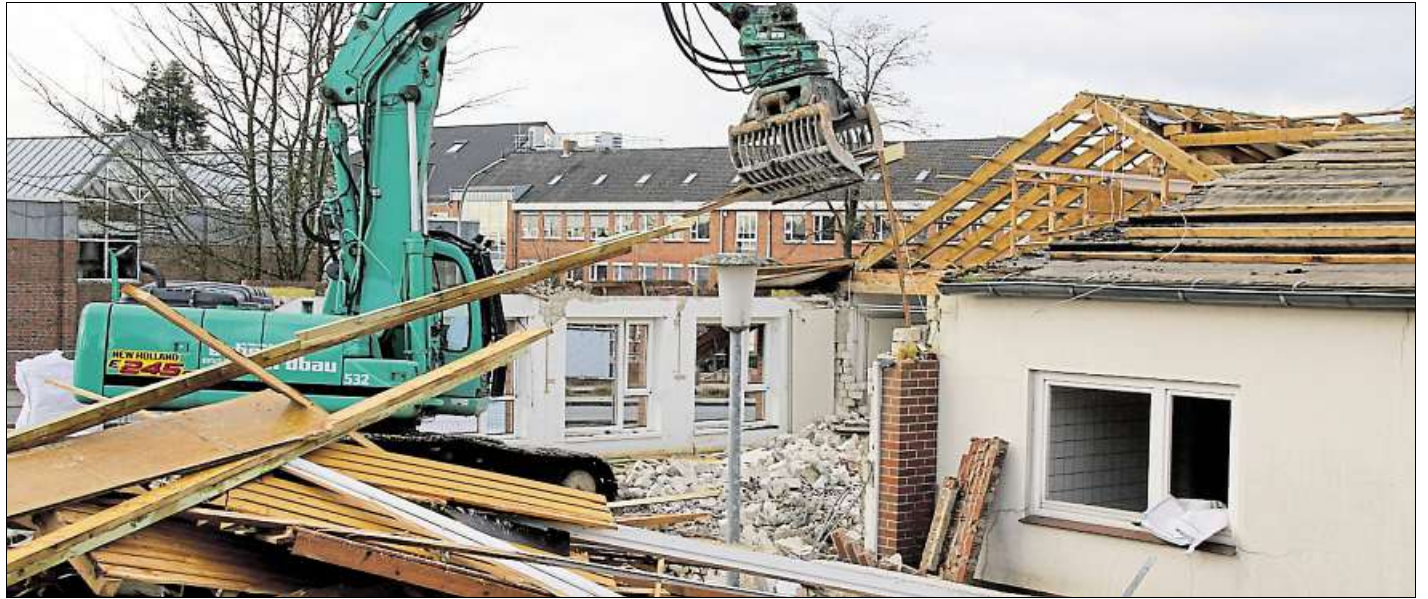
Abriss der alten BBS-Holzwerkstatt (Trakt F) an der Deekenstraße: Das eingeschossige Haus muss einem zweieinhalbgeschossigen Gebäude weichen, in dem Werkstätten und Unterrichtsräume entstehen.
