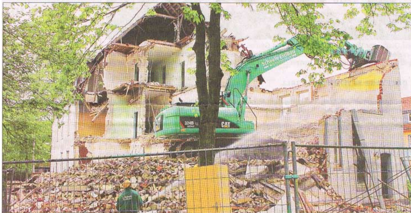
Ein Zuhause wird dem Erdboden gleich gemacht: Das Haus Butjadingen wird abgerissen.
