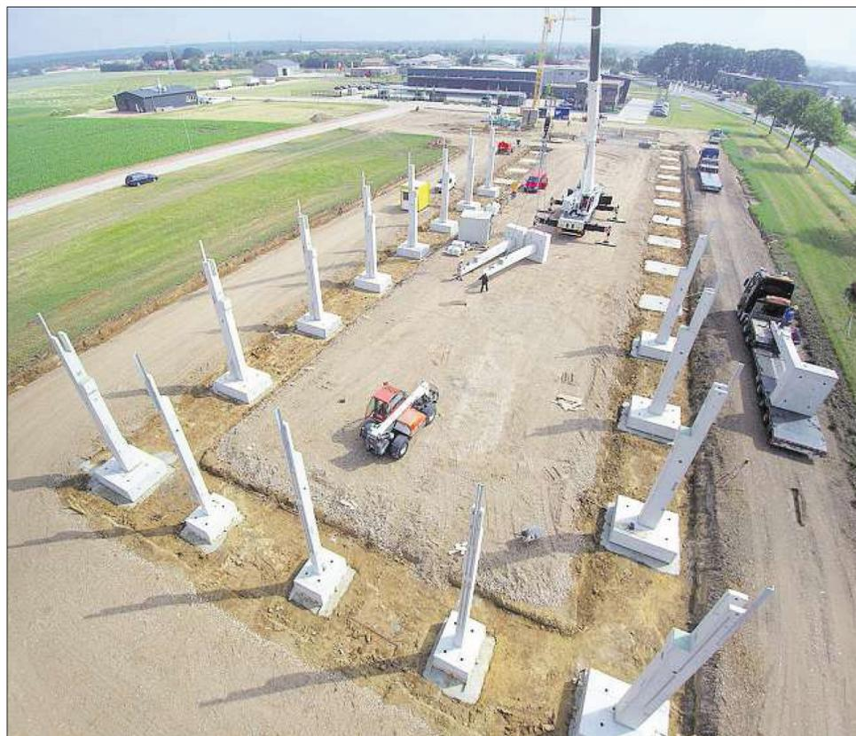
Scheele-Neubau in Arbeit: Die Hallenbauer sind damit beschäftigt, 28 Träger mit einem Eigengewicht von je 16 Tonnen auf die Fundamente zu setzen.
