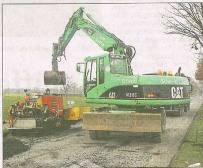
Die Arbeiten an der L776 sind in vollem Gang. • Foto: Henseler
