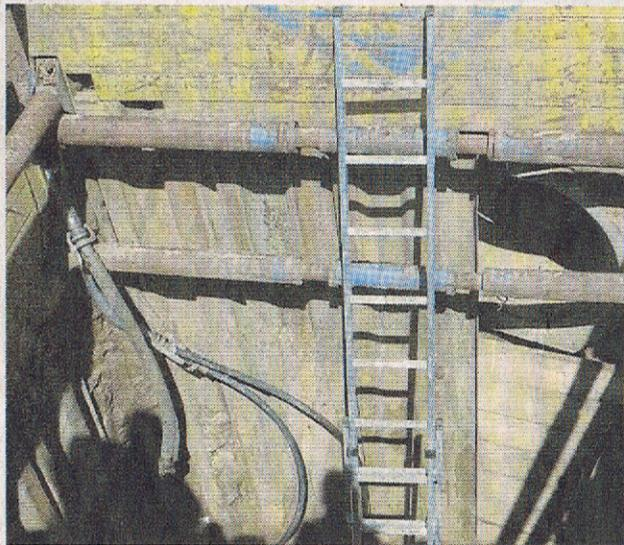
**In der Tiefe** wird der Kanal für den Notabschlag neu gelegt, um Regenwasser weiterleiten zu können.
