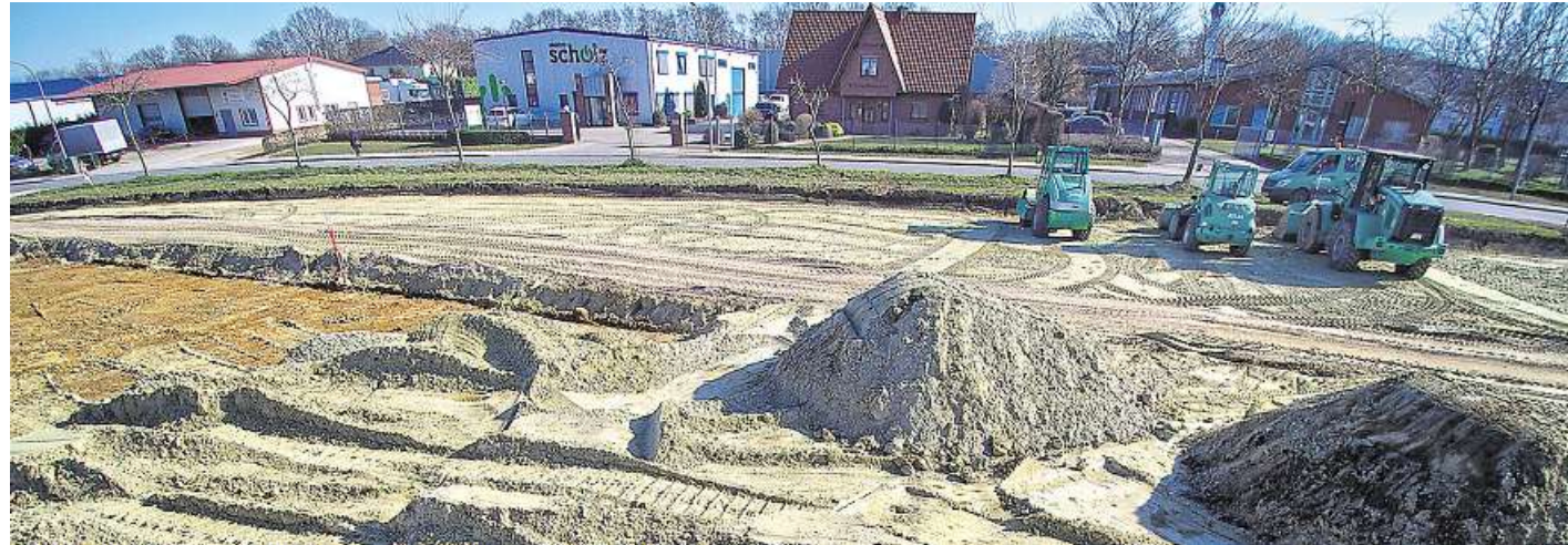
Derzeit noch eine Baustelle: Das Gelände an der Dügstruper Straße, auf dem die Firma FVG Fahrzeugbau eine neue Halle mitsamt Verwaltungsgebäude beziehen wird. BILD: PETER KRATZMANN
