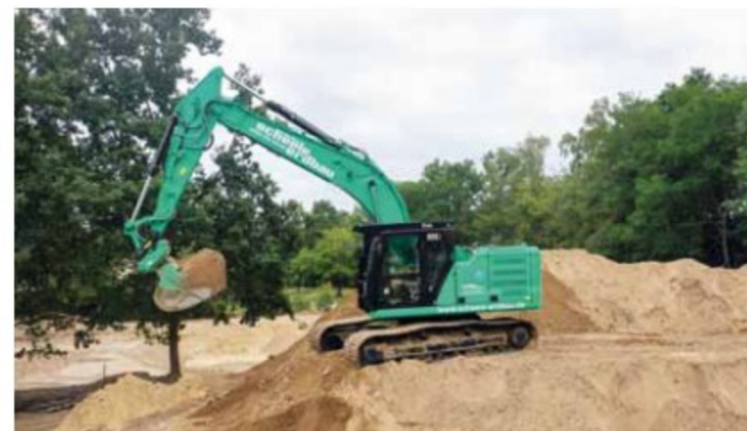
Verspricht Vorteile in der Erdbewegung: die neue Baggenergeneration.
